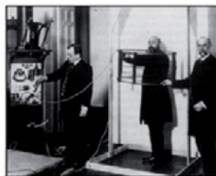
Figure 7 : Expériences de D'Arsonval (à gauche), Thompson (au centre) et Magnusson (à droite) : des volontaires placés dans une large bobine de cuivre dans laquelle circulait un courant alternatif ont rapporté avoir vu des éclairs lumineux (phosphènes) dans leur champ visuel.
