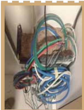
Figure 5 : Isolation des câbles par utilisation du sable
