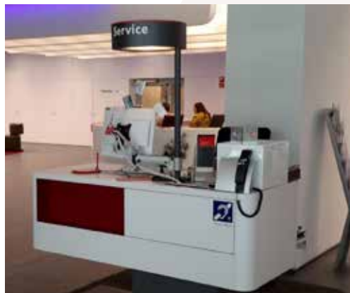
Borne d'accueil équipée d'une boucle magnétique
